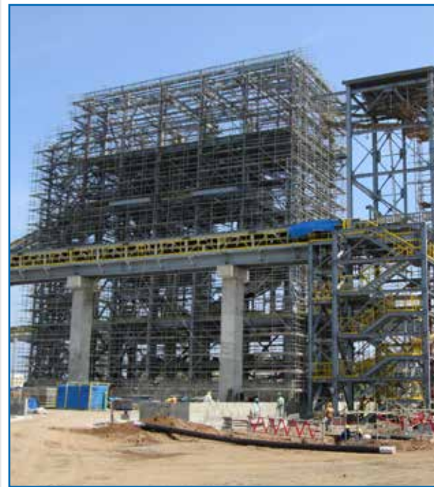
LẮP DỰNG TẠI CÔNG TRƯỜNG
