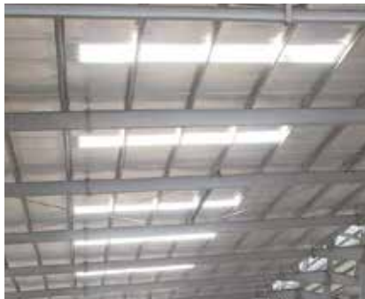
Tấm mái lấy sáng ↑
