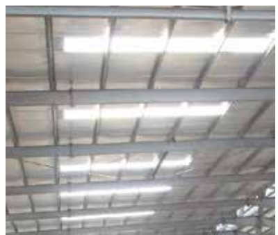
Tấm mái lấy sáng ↑
