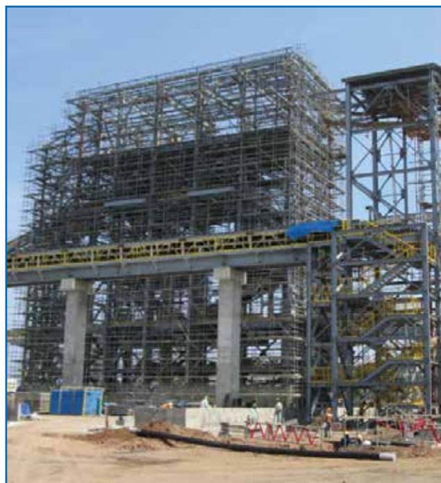
LẮP DỰNG TẠI CÔNG TRƯỜNG
